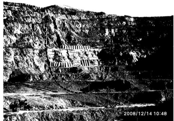
图 3 白云鄂博铁矿东矿 C 区边坡 3#滑体
