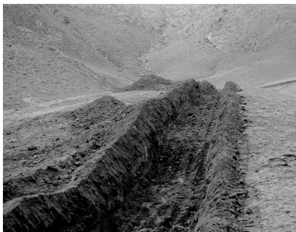
图1 内蒙古乌拉特中旗野狼沟矿点异常高值点的构造蚀变带部位的槽探工程
