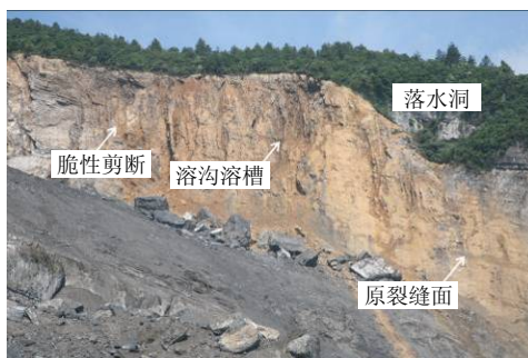
图 7 前缘关键块体侧壁岩溶发育带及脆性剪断面
