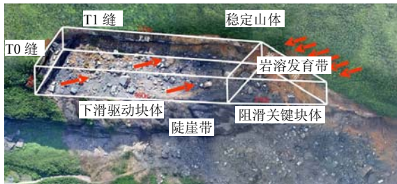
图 6 武隆鸡尾山滑坡体结构
