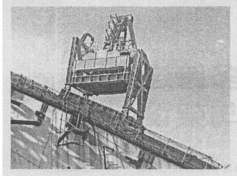
图4 桥面吊机安装完成
