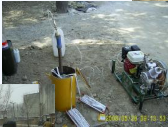
空气压缩机洗井
