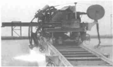
图3 大功率二次雾化电弧喷涂设备在桥面施工
