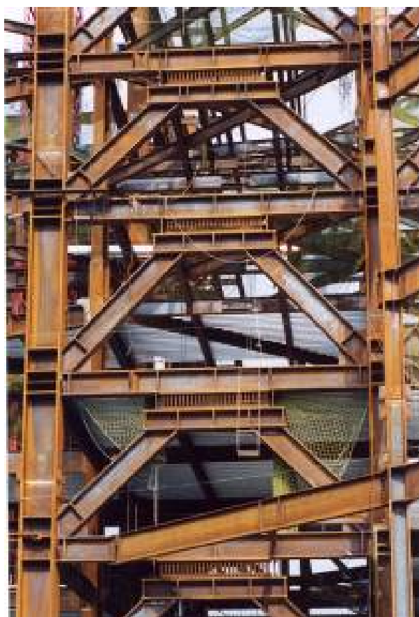
圖 4.11 京華城結構體內 TADAS 阻尼器
