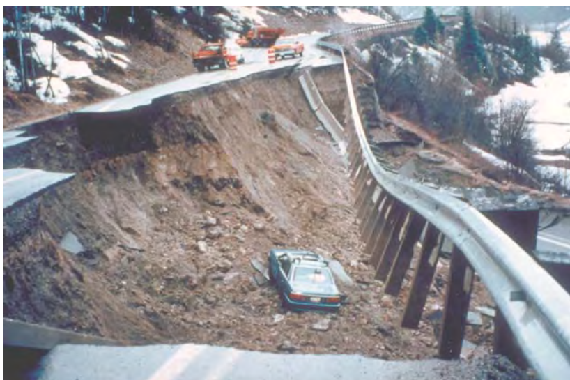
图 1-7 滑坡使公路交通中断，甚至造成车毁人亡的惨剧
