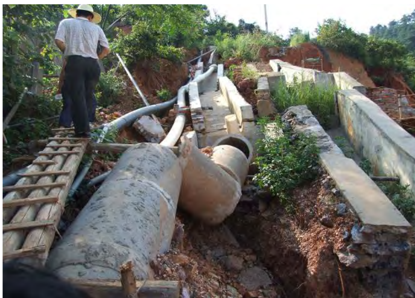
图 1-6 滑坡使水渠和涵管破坏
