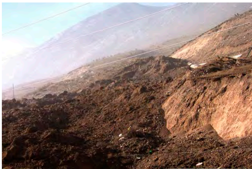
图 1-10 半山腰的引水渠渗漏，斜坡土体中的含水量增大，发生滑坡
