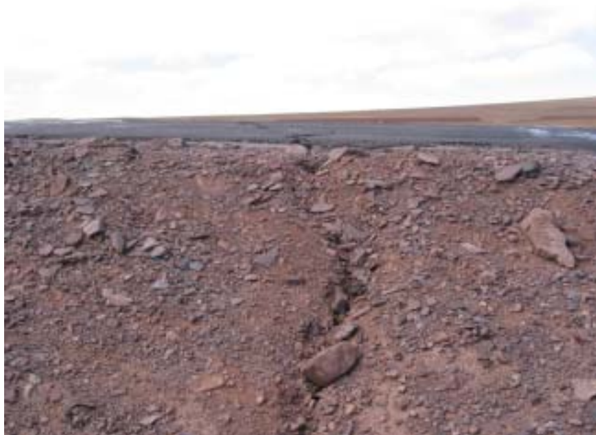
图 181 风火山北麓构造裂缝穿切破坏青藏公路
