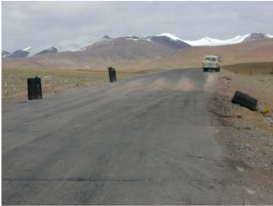
图 173 唐古拉山北断裂破碎带的不均匀冻胀导致青藏公路塌陷变形 ( 镜头向北，摄于 2001 年 3 月 )
