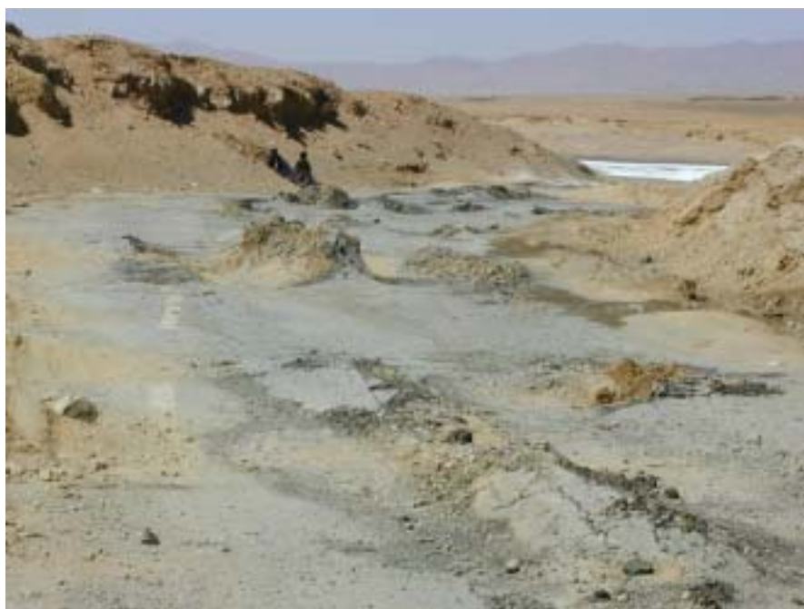
图 172 安多盆南活动断裂蠕滑及地下水不均匀冻胀变形相互耦合导致青藏公路变形破坏
