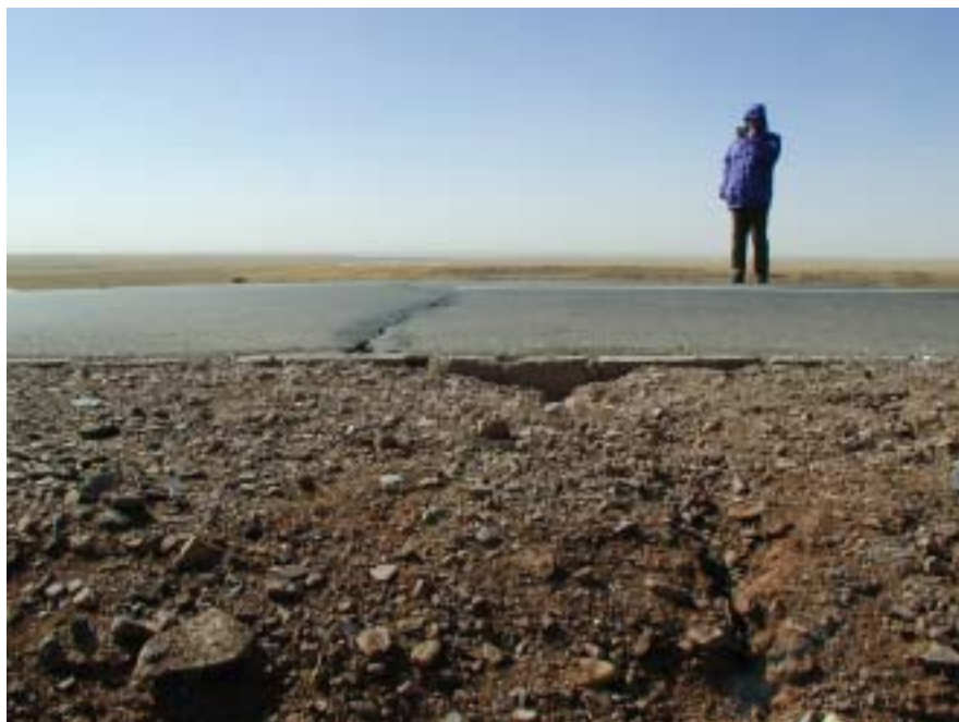
图 179 风火山北麓 2001 年 3 月构造裂缝横切青藏公路
