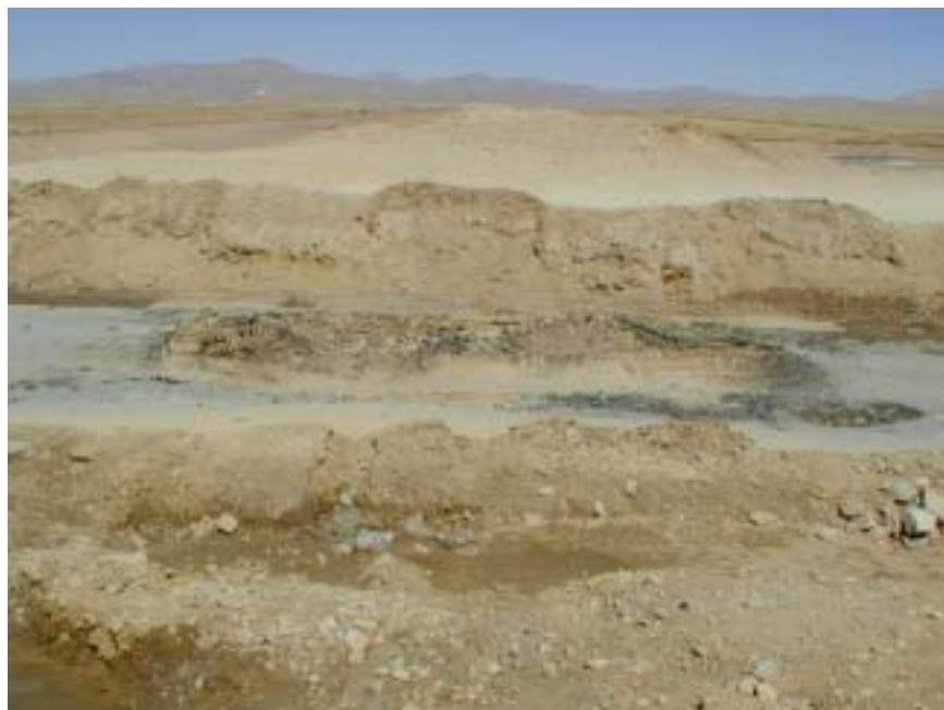
图 171 安多盆南活动断裂蠕滑与不均匀冻胀耦合错断全新世砂土导致青藏公路的路基变形 (镜头向北, 摄于 2001 年 3 月)
