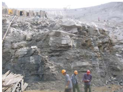
(b) 基坑底部近似水平的卸荷裂隙
