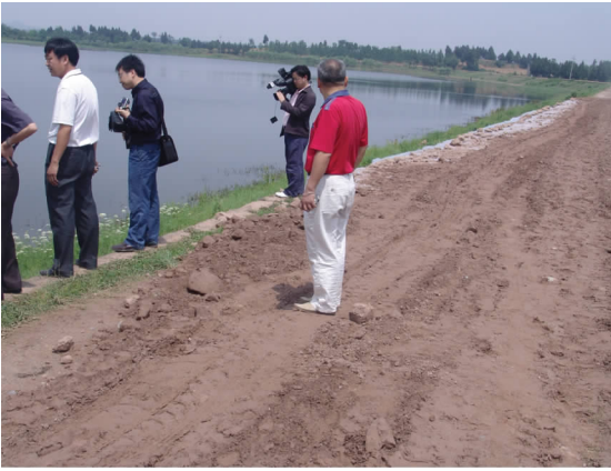
图3 加固后的四川省三台县印盒山水库大坝 Fig. 3 Reinforced Yinhexhan reservoir dam where 6 lengthwise and 56 breadthwise fissures appeared. 受汶川地震影响,坝体出现160m长的纵向裂缝6条、横向裂缝56条,坝顶垂直沉降30cm,迎水面坝体向库心整体下陷,坝底外侧多处出现严重的渗水现象,烈度达Ⅶ~Ⅷ度;照片为抢险加固后的景象
