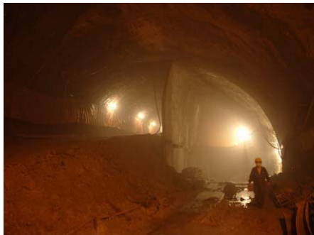
图 1 厦门海底隧道风化槽段 CRD 工法施工 [2~6]
