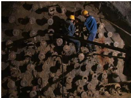
图 2 厦门海底隧道强风化槽掌子面注浆施工 [2~6]
