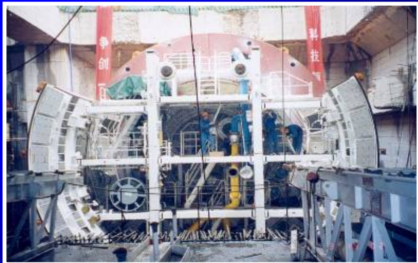
大连路隧道 \Phi 11.22\text{m} 泥水平衡盾构安装、施工
