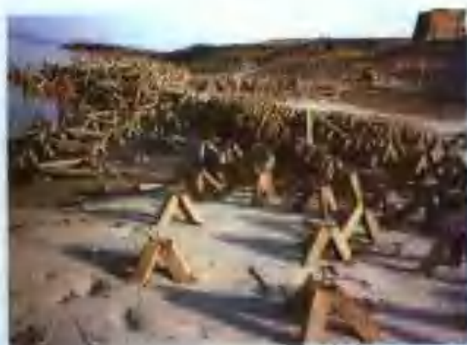
长江九江段赤心堤框架群护岸效果(2)
