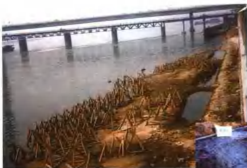
南昌大桥桥头框架护岸
