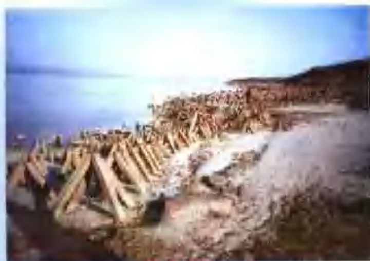
长江九江段赤心堤框架群护岸效果(2)
