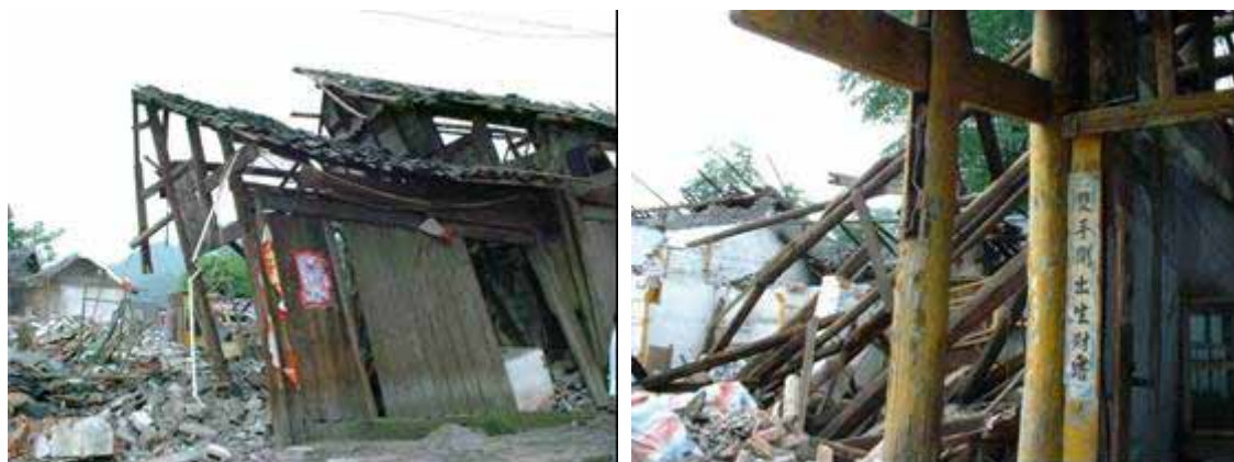
绵竹市遵道镇的木造住宅受灾情况(右图也一样)。与日本一样采用的梁-柱结构（摄于 6 月）
