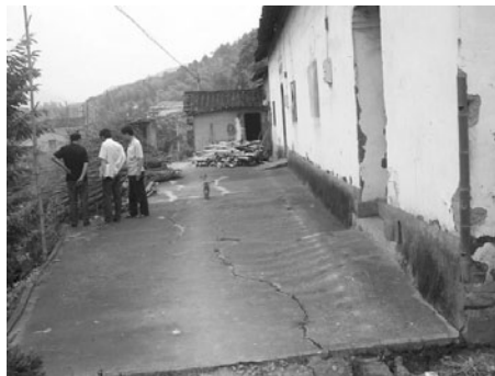
照片 1 后缘房屋加载引发滑坡
