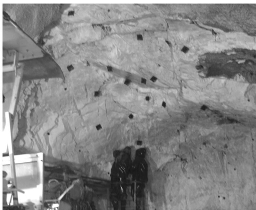
图 4 水涨式锚杆施工
