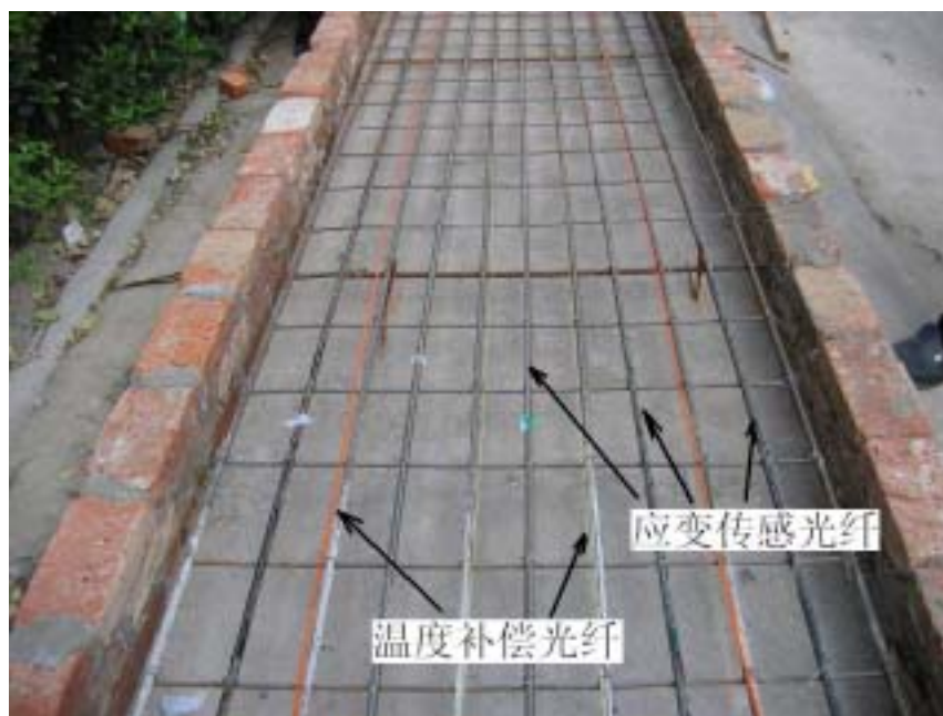
图 6 光纤传感系统布置
