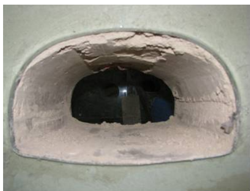
(a) 隧道开挖后,拱顶零星掉渣
