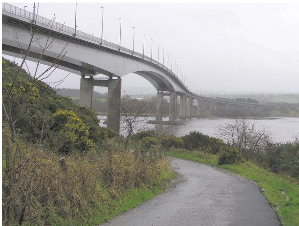
总长522 m的三跨变高度连续钢箱梁桥
