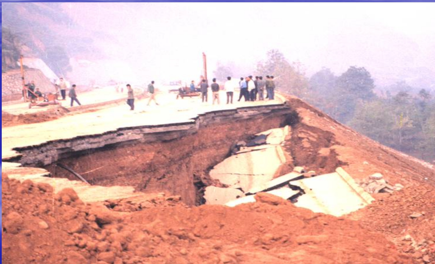
图5 洛三线垮塌的坡间挡墙
