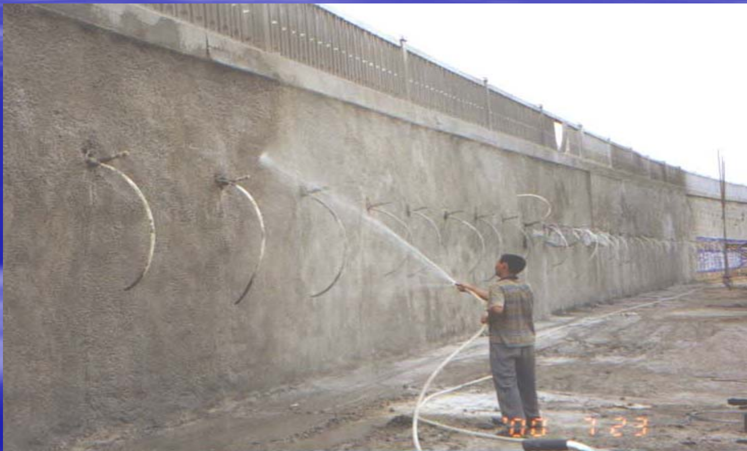
图11 喷层养护图
