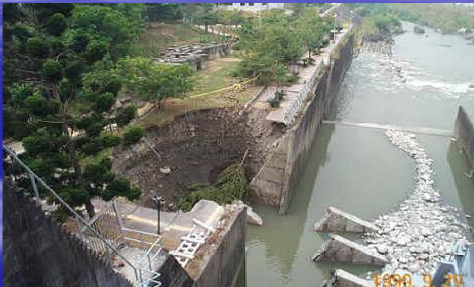
图3 垮塌的重力式挡墙
