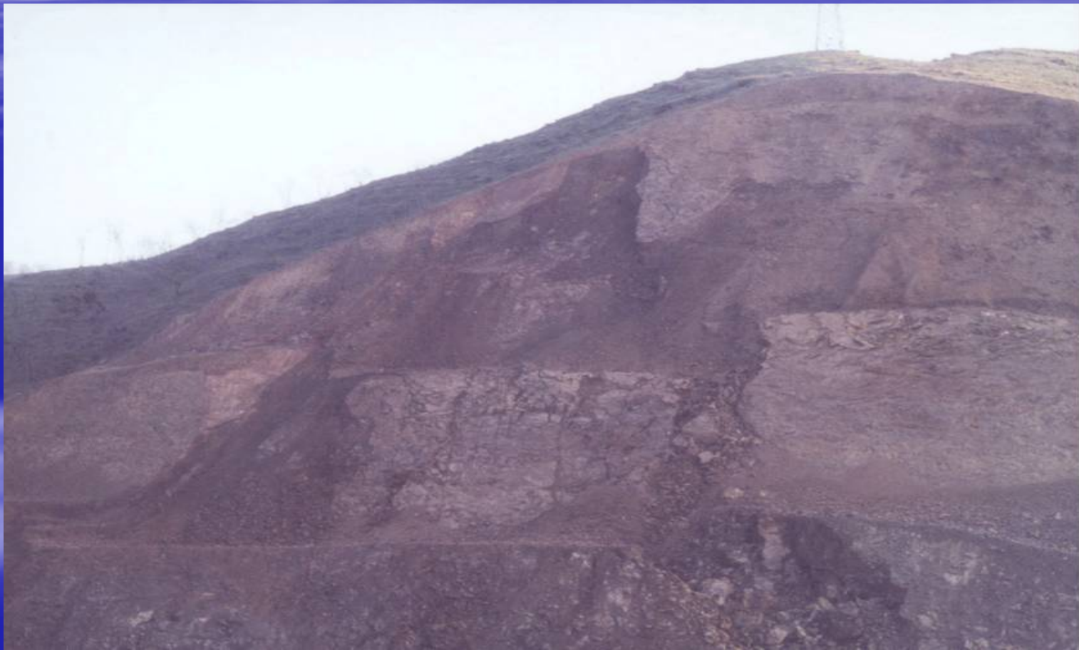
图2 失稳的坡间挡土墙
