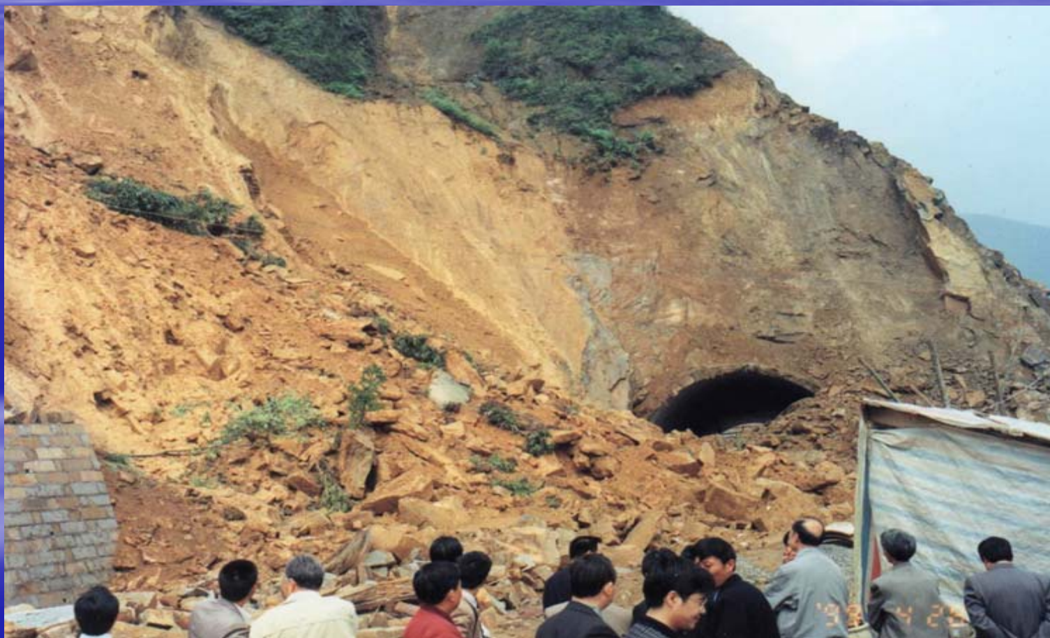
图4 垮塌的护坡挡墙
