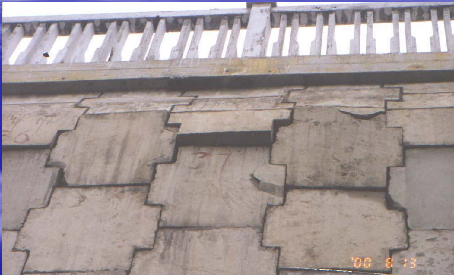
图1 失稳的加筋土挡土墙
