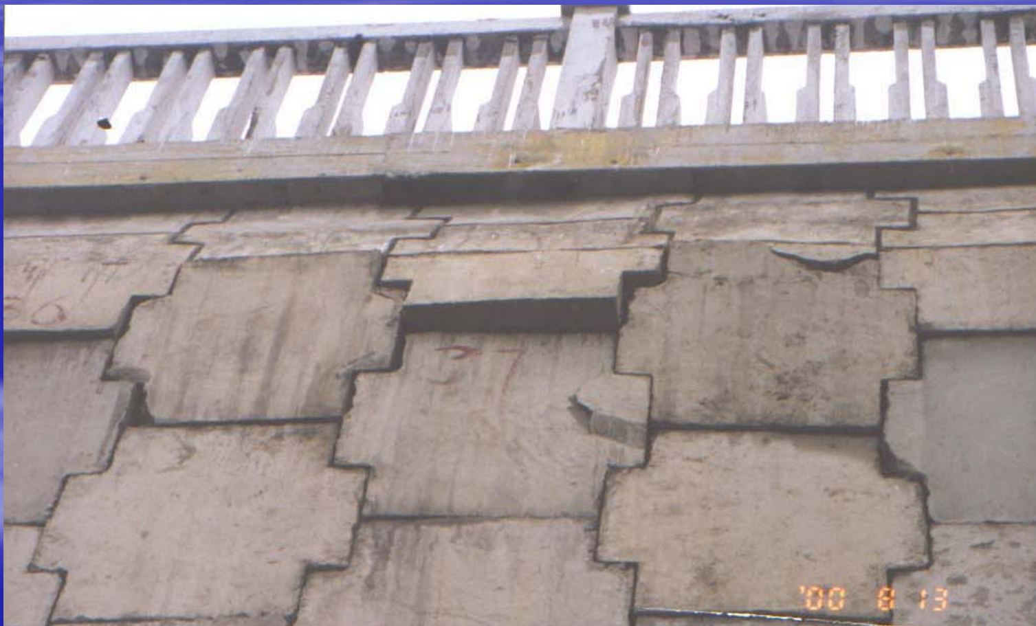
图7 加固前的失稳加筋土挡土墙
