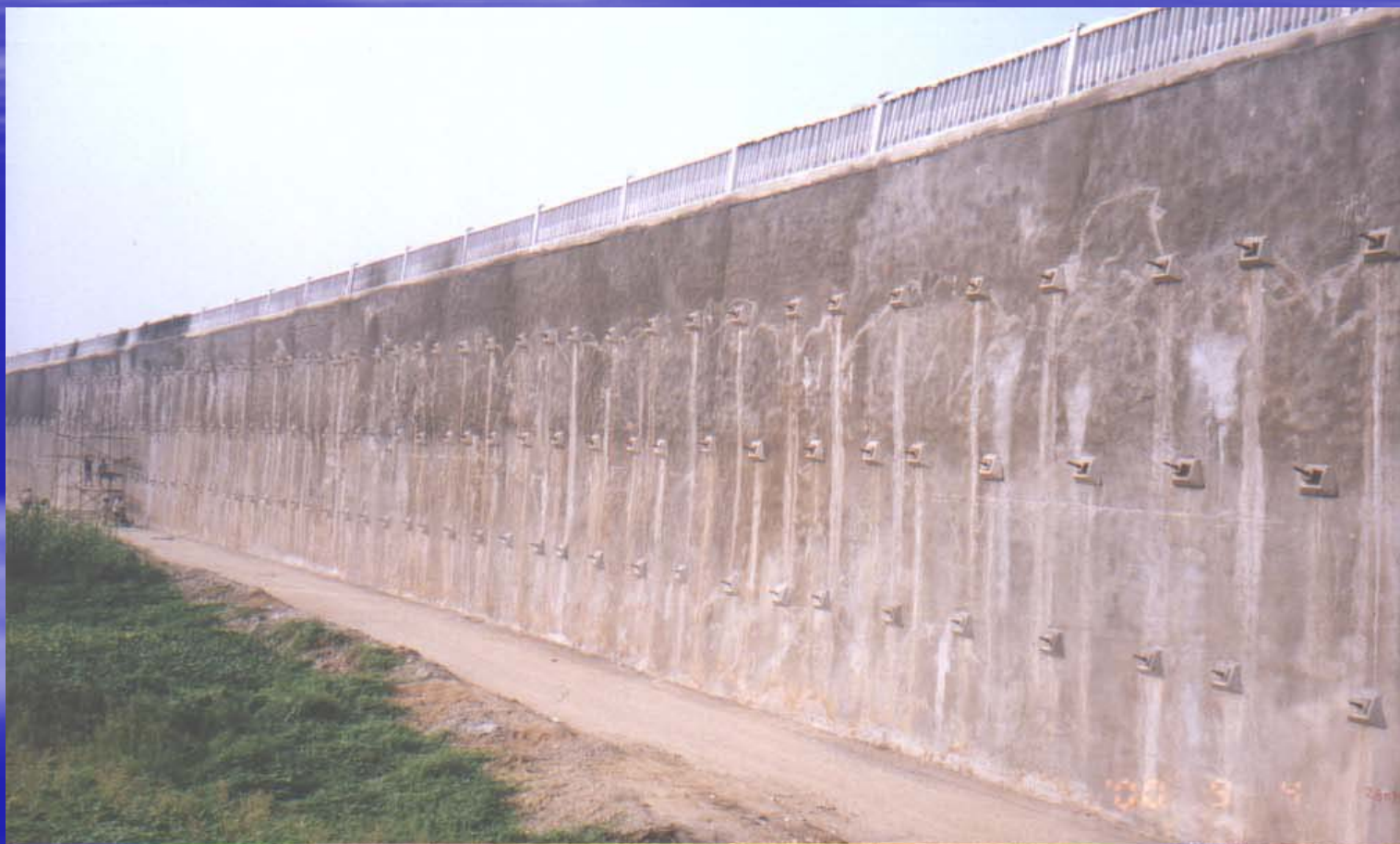
图12 加固后加筋土挡土墙
