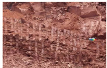
照片 4 323 国道扩宽工程仁化茨菇塘段新开的路堑，出露长坝组二段新鲜的泥质粉砂岩(2009.04.25, 彭华摄影)
