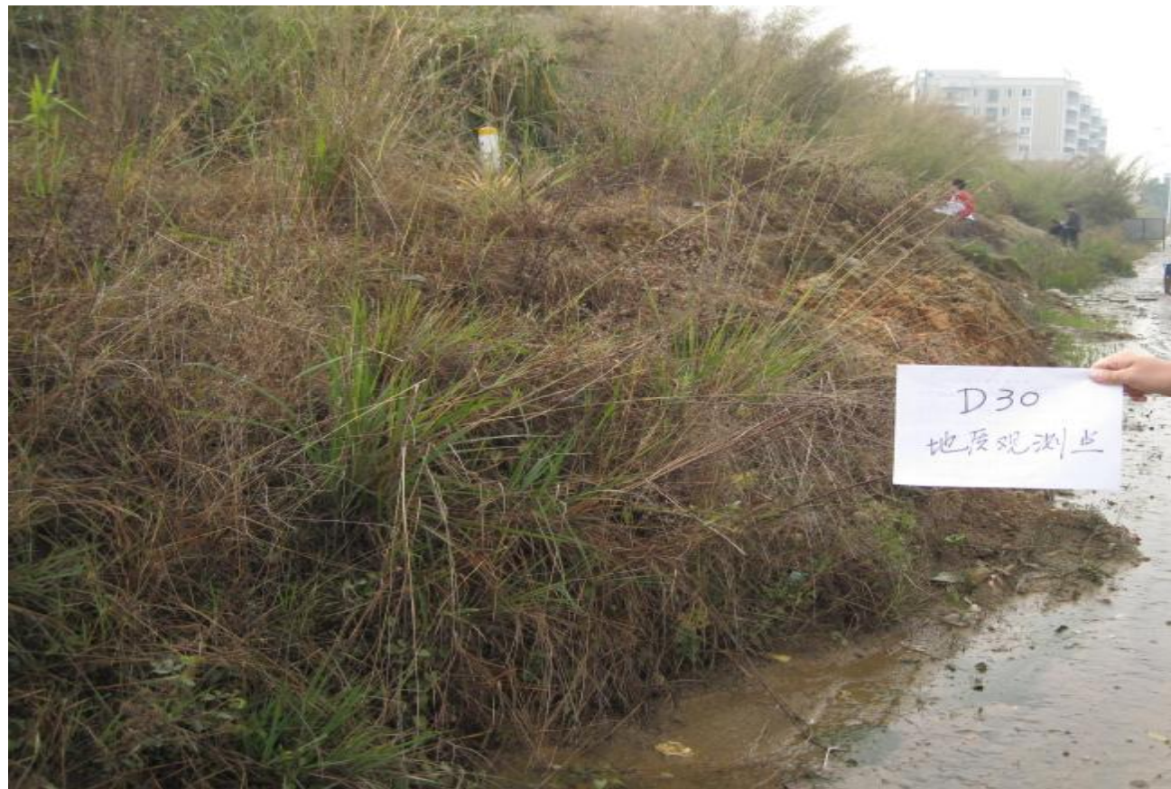
照片 3-5 滑坡前缘剪出口
