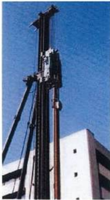
图 5.5 配合钻土机的液压静压法
