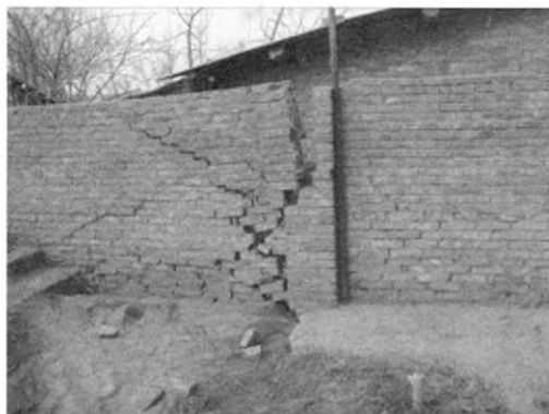
图 2 围墙开裂
