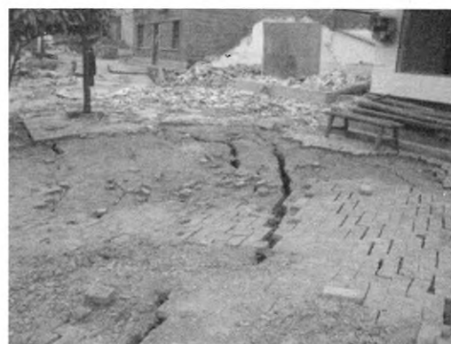
图 3 地面张裂缝
