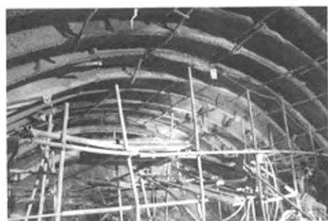
图3 塌方体处初期支护临时加固和管棚施工
