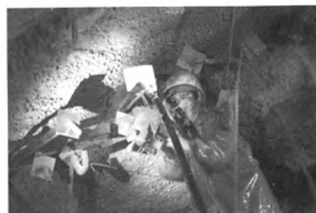
图5 管棚和小导管注浆
