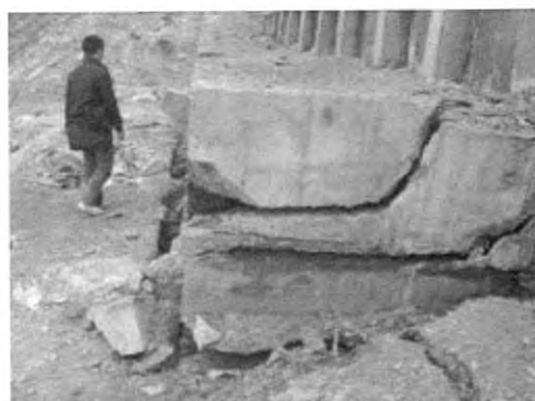
图3 下部防护构件破坏
