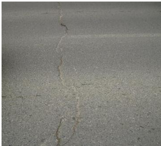
图 4.2.1-4 横裂缝
