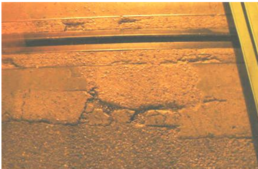
4.5.1-1 过渡带混凝土碎裂
