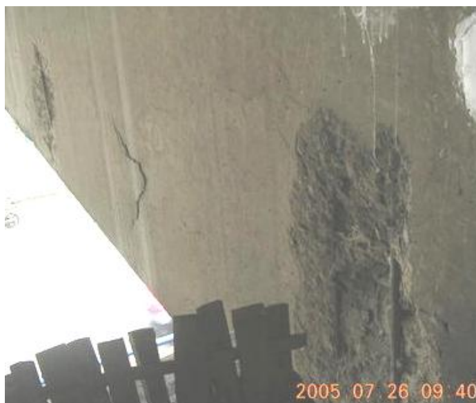
图 5.2.2-6 混凝土碱骨料反应
