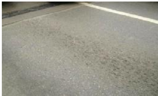
图 4.2.1-3 沥青混凝土铺装层车辙
