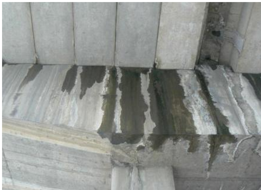
图 5.2.2-4 混凝土表面渗出物
