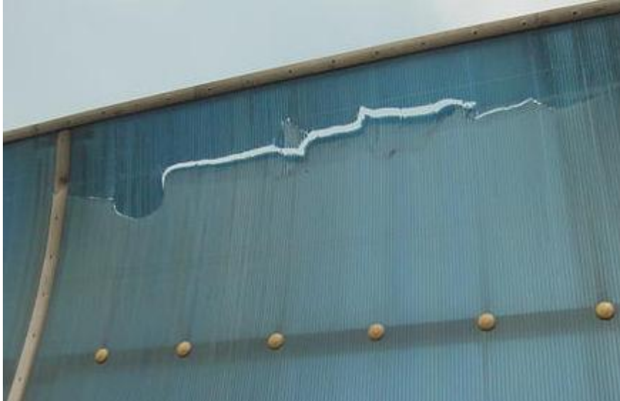
图 6.2.1 声屏障开裂
