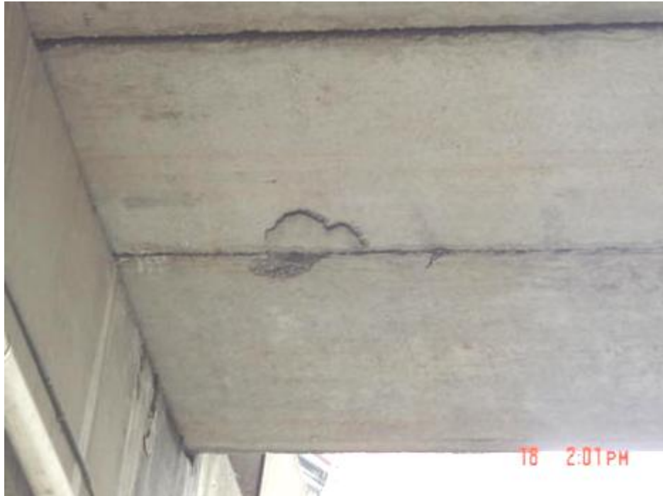
图 5.2.2-3 混凝土剥落
