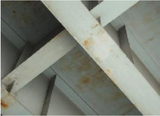
图 5.3.2-2 钢构件的腐蚀
