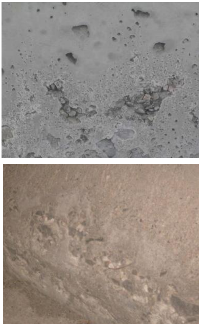
图 5.2.2-2 混凝土表面麻面
