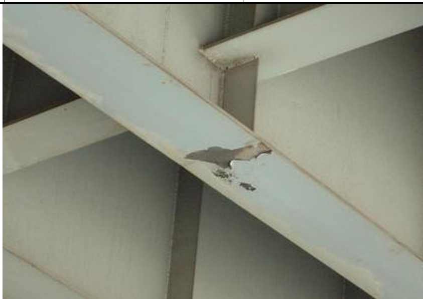
图 5.3.1-1 油漆剥落
