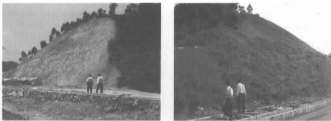
图 1 惠河高速公路二期原始边坡与治理后的边坡比较
