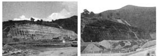
(a)客土喷播施工前坡面情况 (b)客土喷播施工后 5 个月的效果
