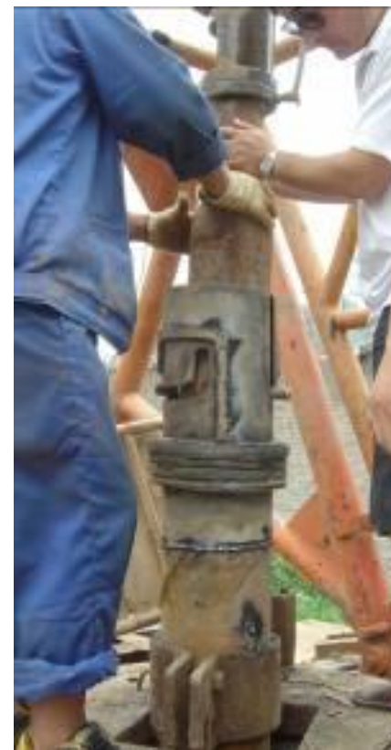
PVC-U塑料管井破碎爆裂事故处理中采用的补管上端 密封装置和挂口
