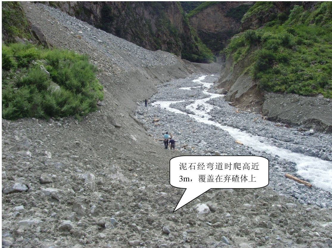
照片 4 四川省甘孜州康定县泥石流沿弃碴块石堆爬高 3 米
