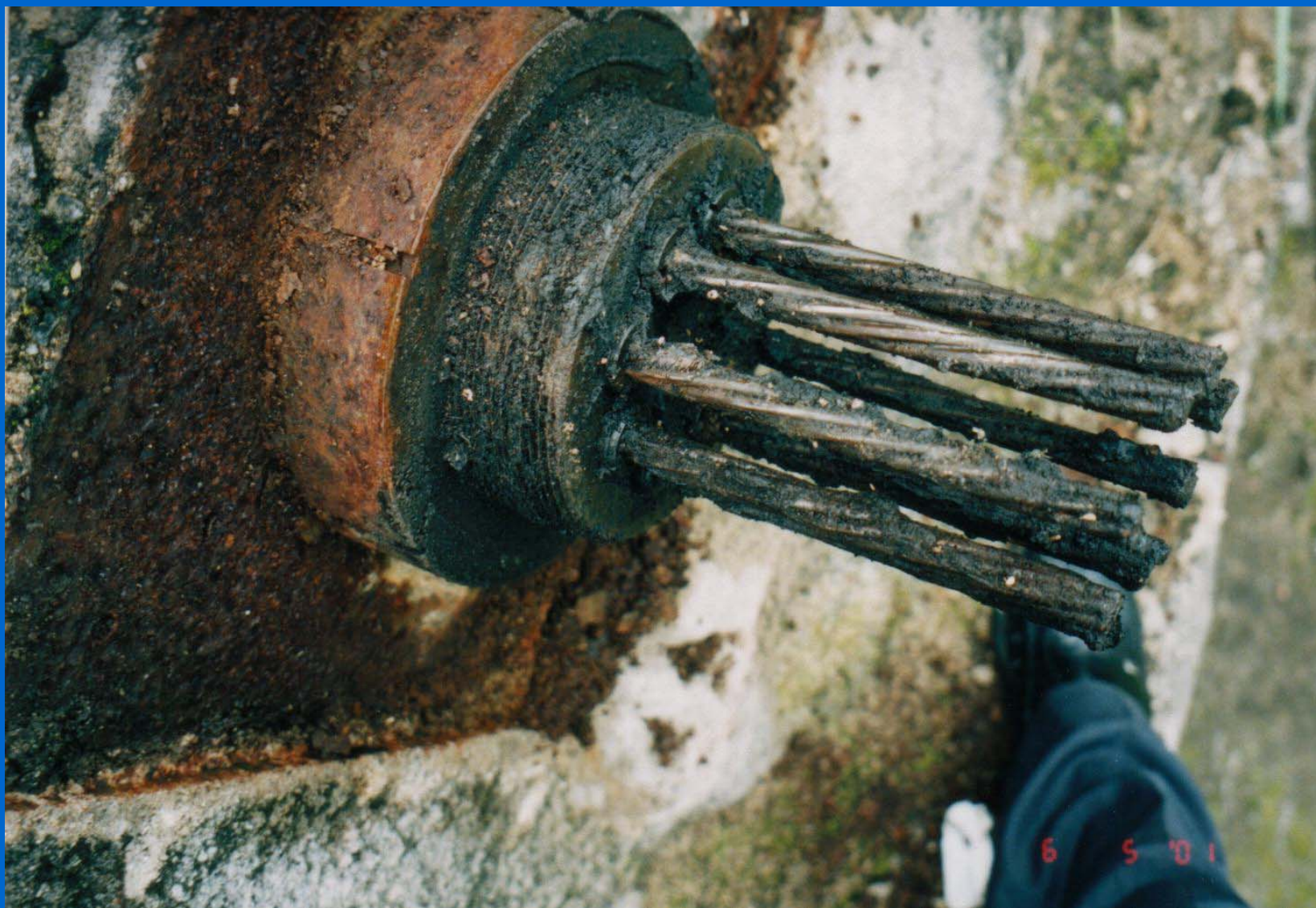
锚索使用 10 年后锚头防护油脂漏光
