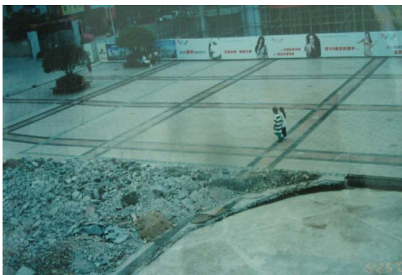
超市 A 区前半段长 30 米，宽 66 米地下室结构在浮力作用下不均匀上浮 200~300mm
