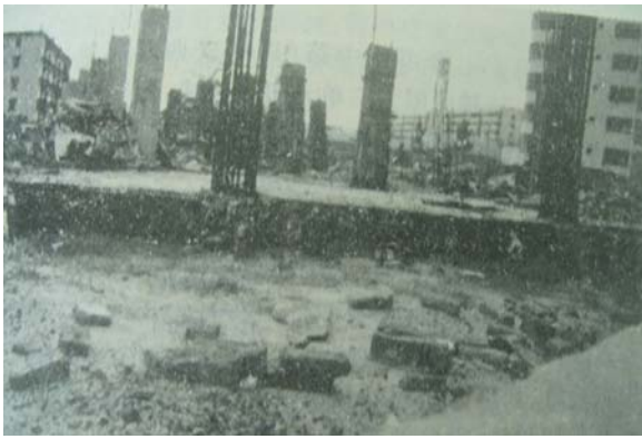
经归位处理后西高东低，差 900mm
