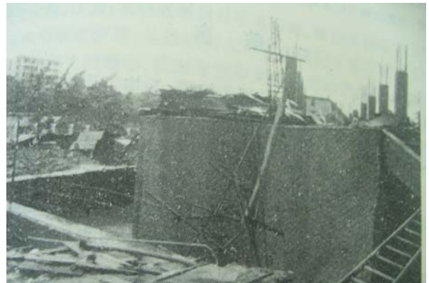
地下室结构上浮高出地面 4.5 米
