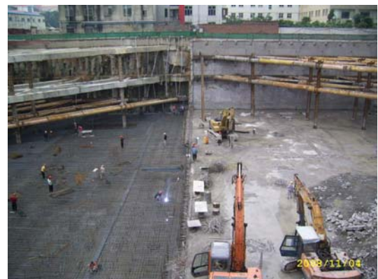
左侧为三道支撑，右侧为两道钢管支撑
