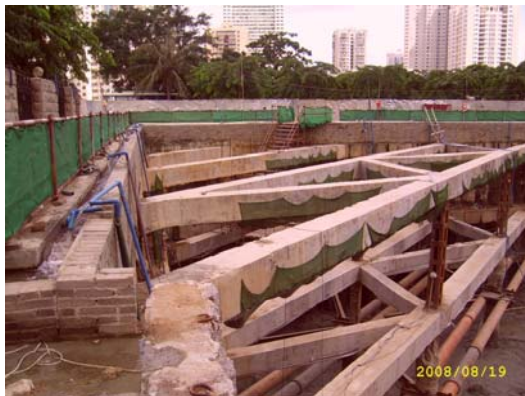
钢筋混凝土内支撑二层
