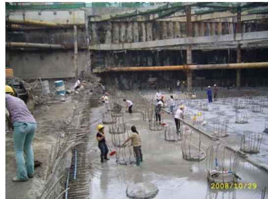
内支撑完成后进行垫层施工情景
