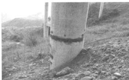
图 1 张家坪一号大桥桥墩环向裂纹
