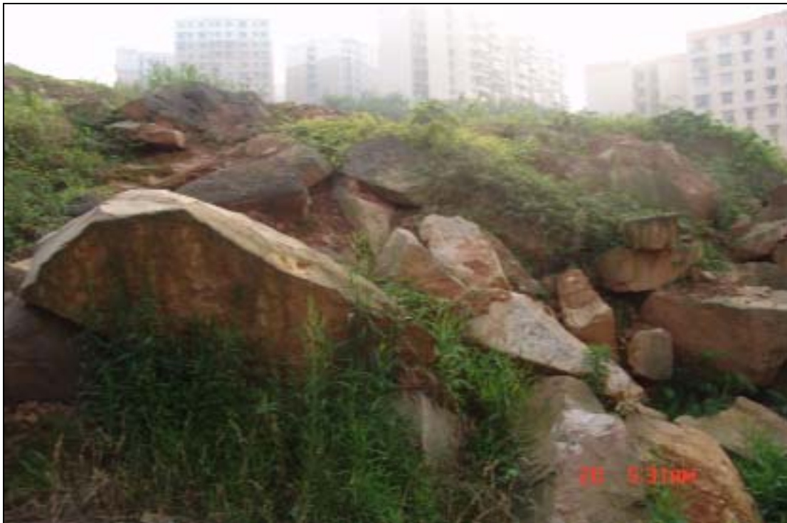
照片 2 坡脚滑塌堆积体
