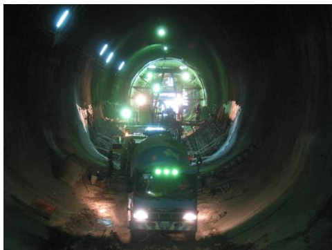
圖5.3.5 仰拱襯砌混凝土澆置作業
