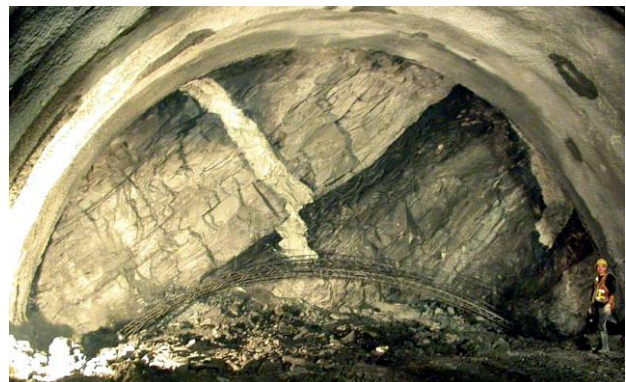
圖5.3.2 開挖面含煤層及斷層
