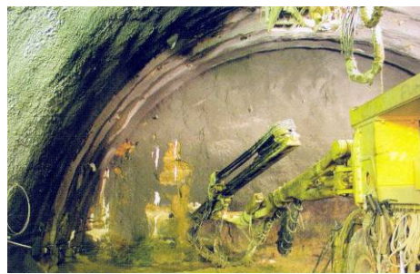
圖5.4.6 林口隧道封面岩栓鑽設
