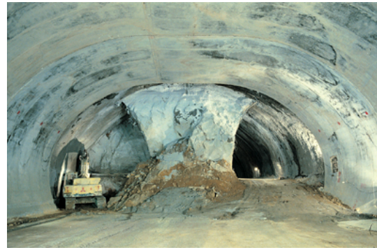
圖5.2.2 新店一號隧道雙側導坑開挖方式
