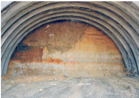
圖5.4.3 林口隧道南洞口開挖面
