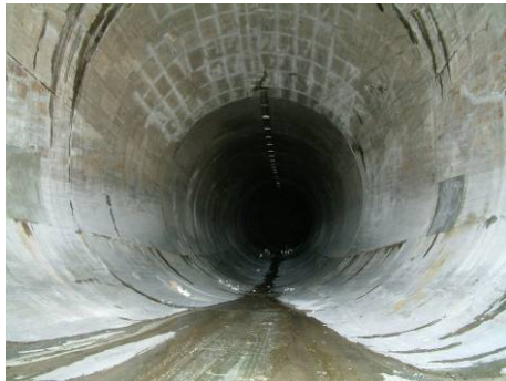
圖5.3.3 分洪隧道漸變段
