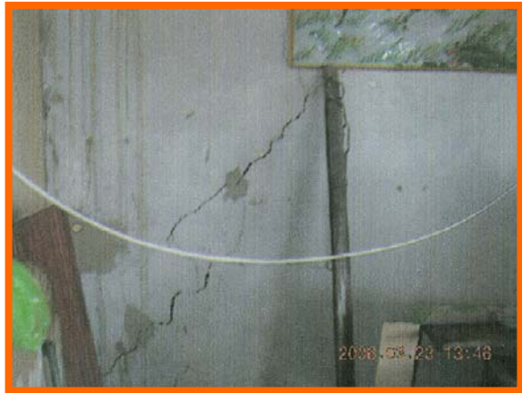
照片 4 墙体裂缝
