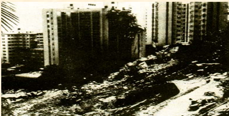
图5-6-30 香港宝城大厦被滑坡冲毁倒塌成废墟
