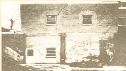
图5-6-23 美国某净水厂工厂墙体开裂与倾斜； 图5-6-24美国某净水厂沉淀池破坏情况
