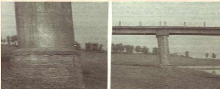
图5-7-8 湖南某高架灌渠支墩倾斜；图5-7-9 高架灌渠支墩严重倾斜开裂
