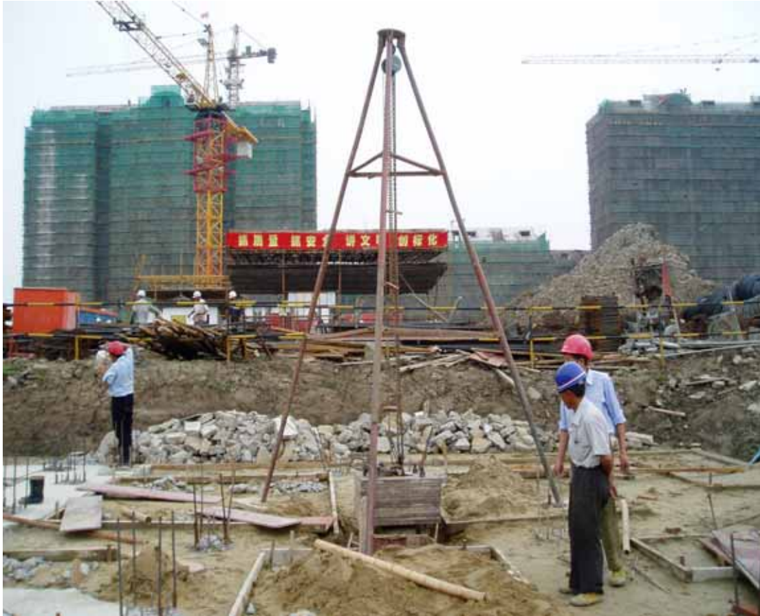
D . 锤的底面与桩面都要水平、平整
