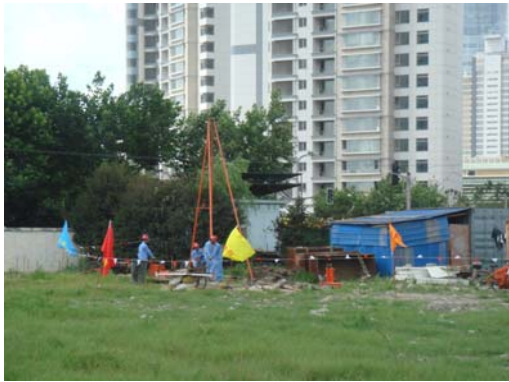
图 5 静力触探试验施工作业
