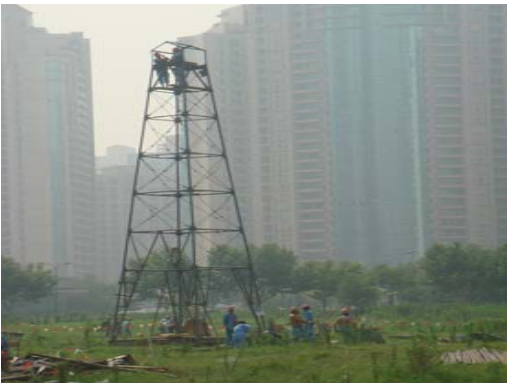
图 3 XY-4 型岩芯钻机施工作业
