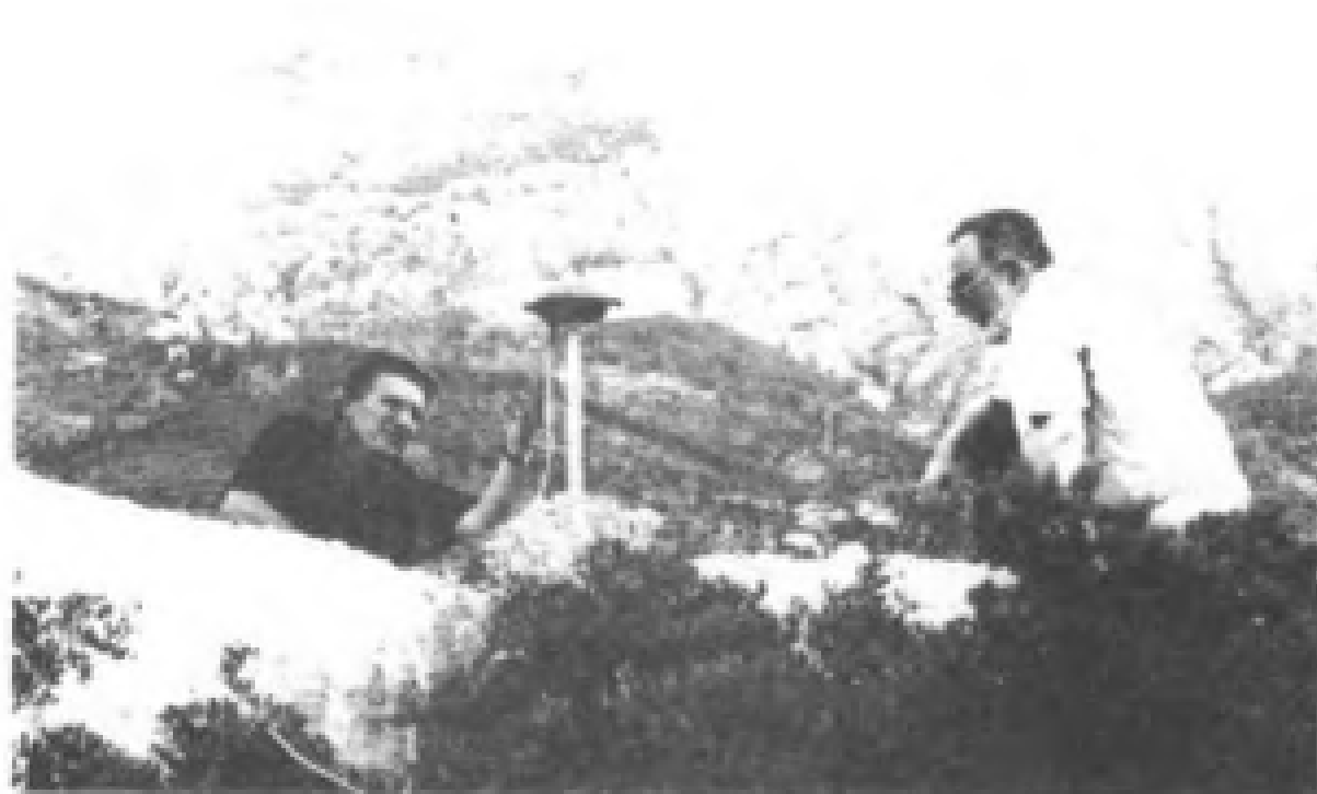
在 CRODYN'98 GPS 网观测期间，萨格勒布大学测量教授克拉斯米尔·克拉克博士与萨格勒布州大地测量局土地测量处负责人日拉柯·梅迪克正在调试 Makarska 观测站的天线偏心差
