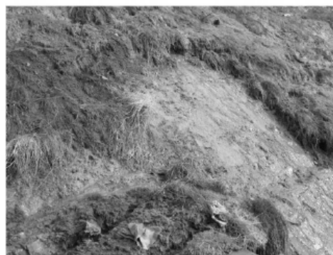
图 1 堆积坝坡面沼泽化
