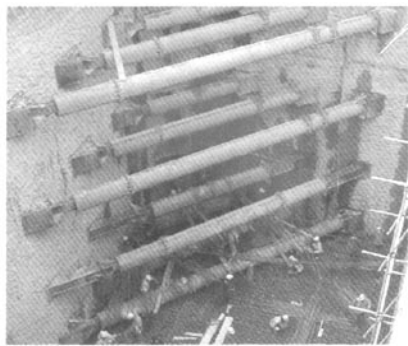
图 1 传统斜撑接头示意图
