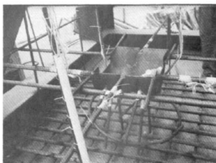
图 2 预埋钢匣子定位及钢筋绑扎
